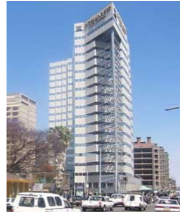
Imagen 2. Edificio Eastgate, Zimbawe. El sistema de ventilación del edificio se basa en los montículos de las termitas Macrotermes Michaelsoni, que mantienen estable la temperatura interior de sus nidos a pesar de las variaciones térmicas extremas del exterior
